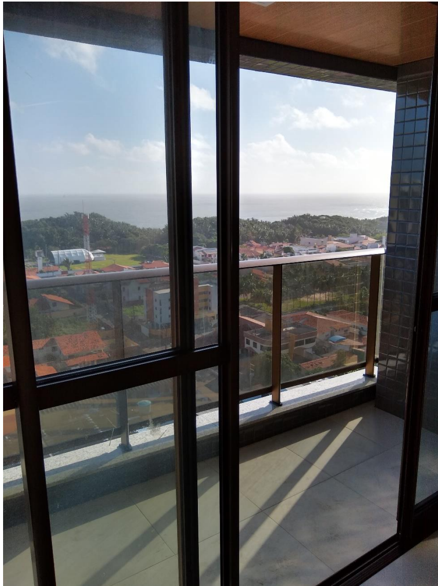
Figura 17 – Vidro utilizado na passagem e no guarda-corpo das varandas
