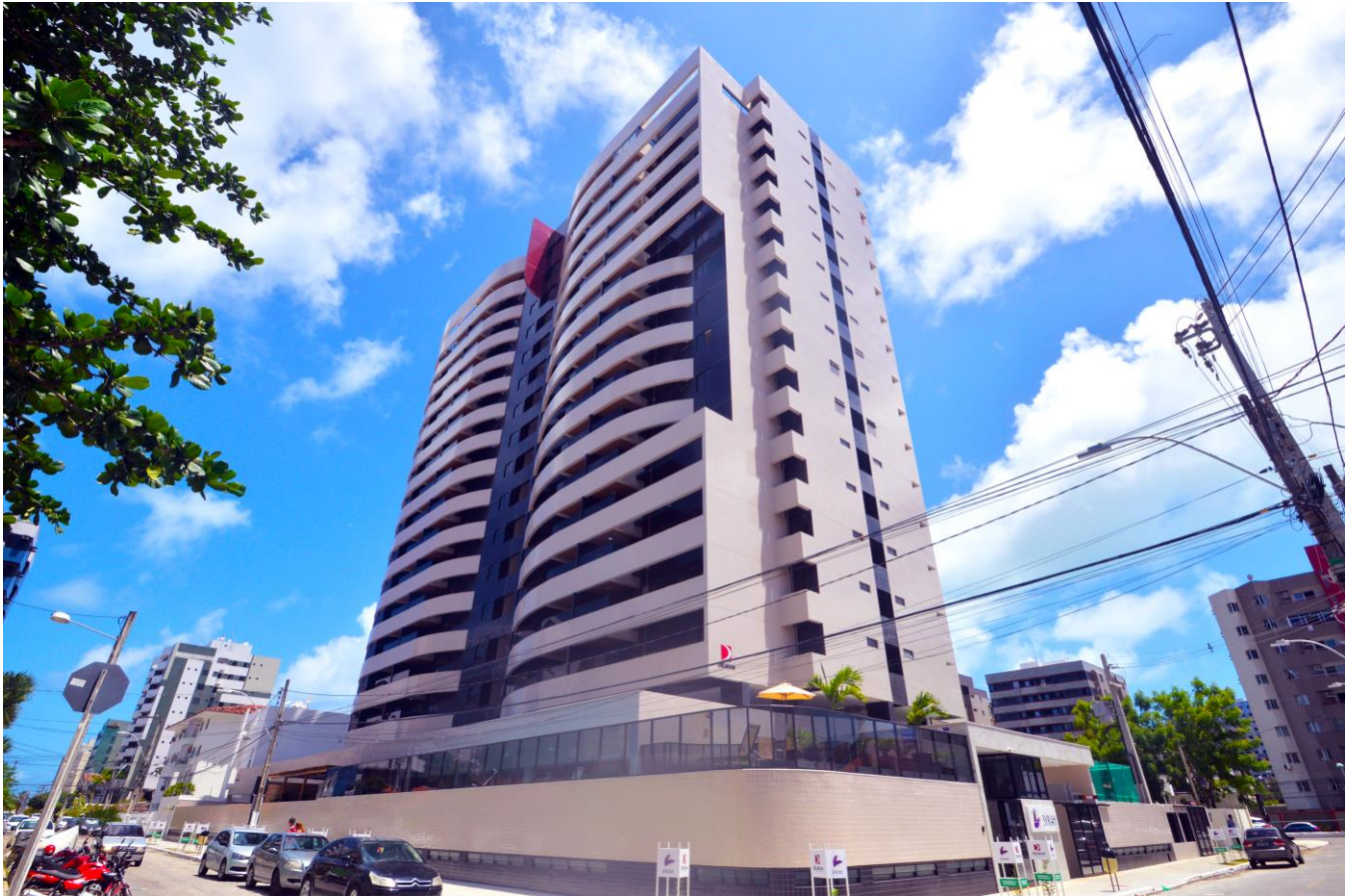
Figura 1 - Perspectiva do Edifício Syrah
