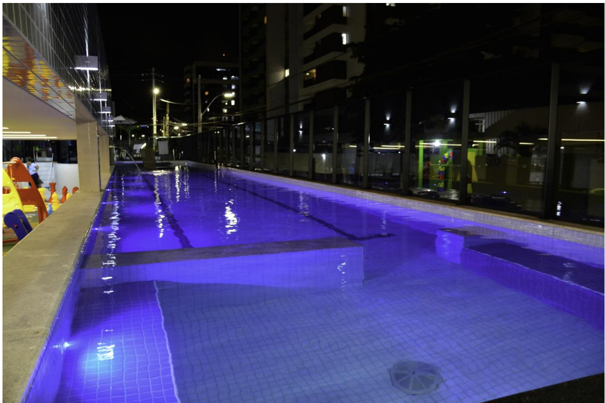
Figura 4 – Deck e Piscina
