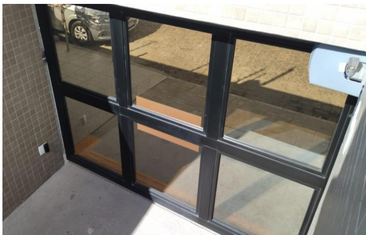
Figura 24 - Portão de veículos
