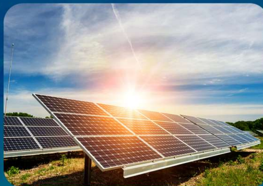
ECONOMIA DE ENERGIA PARA O CONDOMÍNIO ATRAVÉS DE ENERGIA SOLAR FOTOVOLTAICA*11
